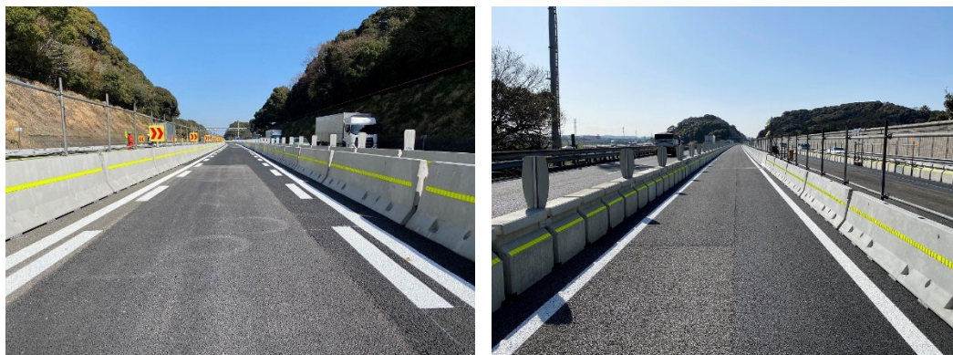
コンクリート製交通規制材による交通規制イメージ
