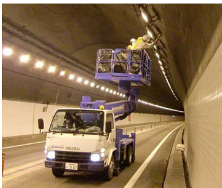
【通行止めによるトンネル内の点検】
