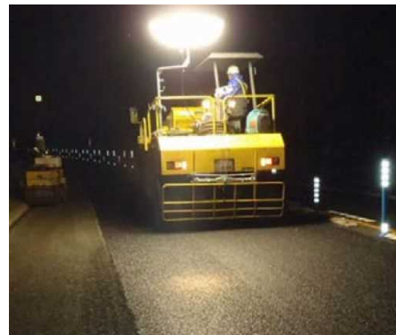
【通行止めによる舗装補修工事】
