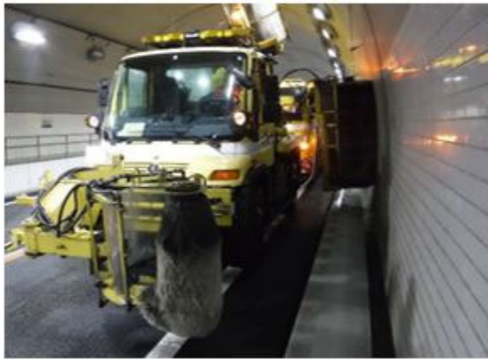
<トンネル壁面清掃>
