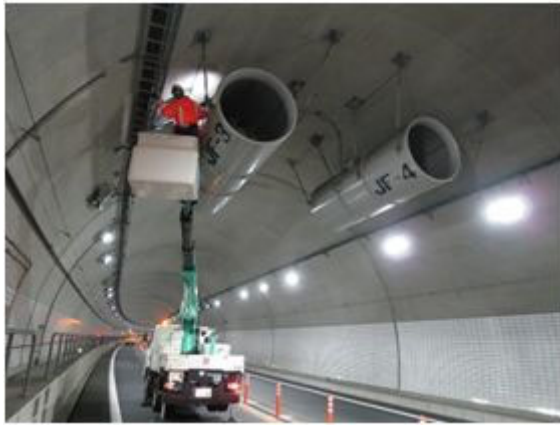
<トンネル点検>
