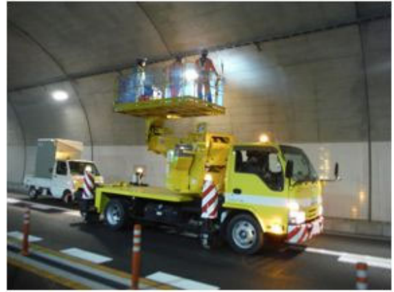
<トンネル照明設備点検>
