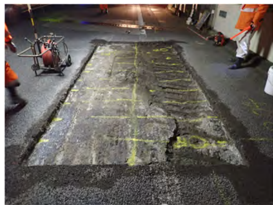
床版上面の状況
