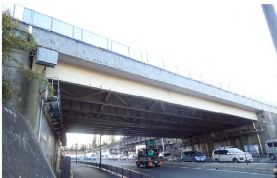
稲荷坂橋の橋梁全景
