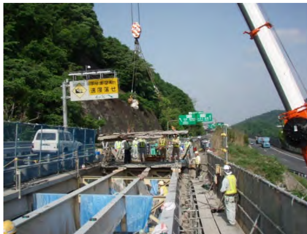
老朽化した床版の撤去
