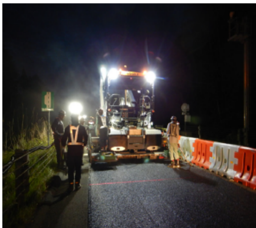
舗装補修工事(イメージ)
