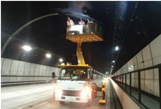
トンネル覆工点検(イメージ)
