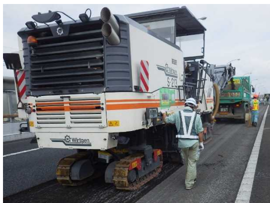
舗装補修工事(イメージ)
