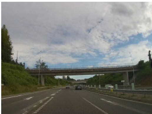
撤去する大徳原橋（駒ヶ根市管理）
