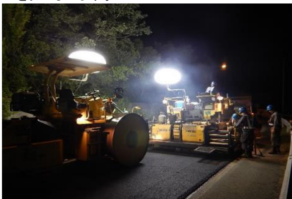
路面損傷箇所の補修(イメージ)
