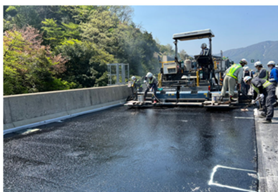
損傷した防水層の再施工状況(イメージ)
