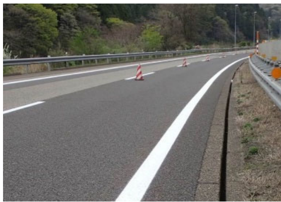
路面標示工の施工(イメージ)
