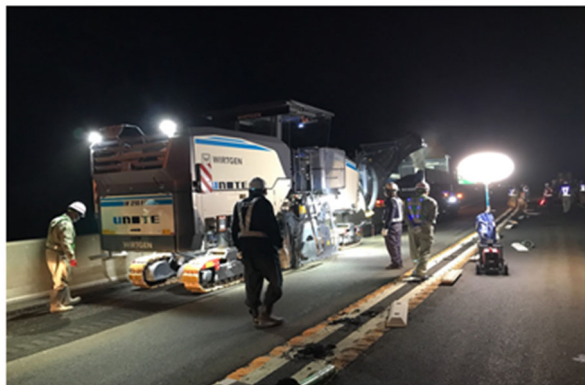
傷んだ舗装撤去状況(イメージ)
