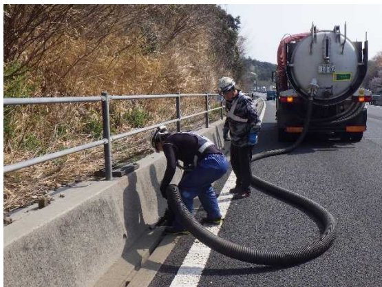
排水溝の清掃
