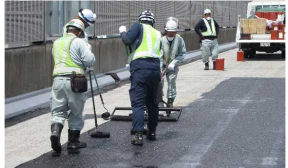
床版防水工の施工状況
