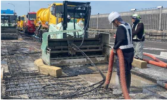
老朽化した床版の補修状況
