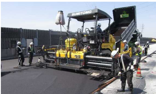
新たな舗装の施工状況
