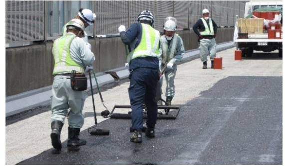
床版防水工の施工状況
