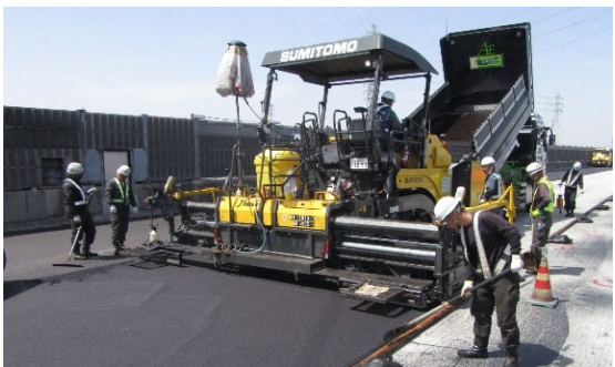
新たな舗装の施工状況
