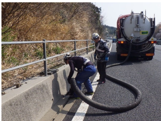
排水溝の清掃
