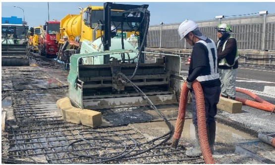
老朽化した床版の補修状況
