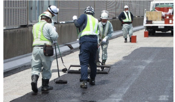
床版防水工の施工状況
