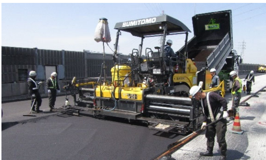
新たな舗装の施工状況
