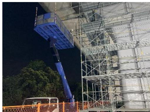
足場設置の例
