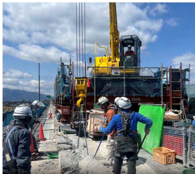
床版取替工事の様子
