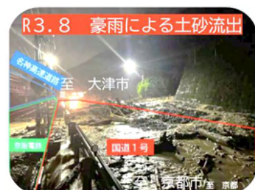
国道1号の被害状況
