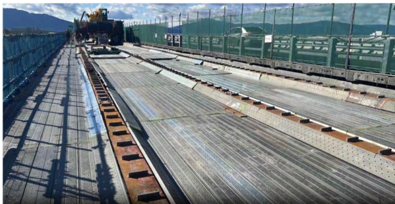
床版取替工事の様子
