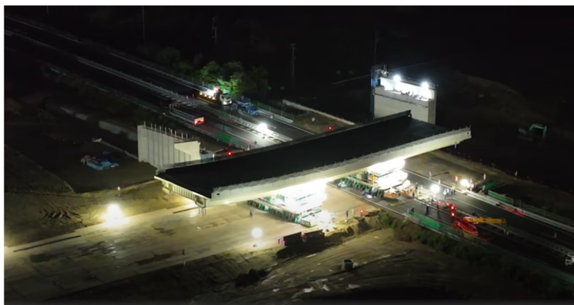
写真1 跨道橋を架ける工事(イメージ)
