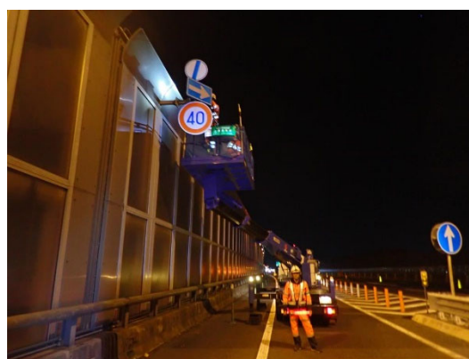
写真3 遮音壁の点検(イメージ)
