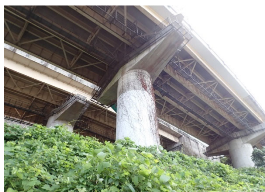
<小山高架橋の橋梁全景>
