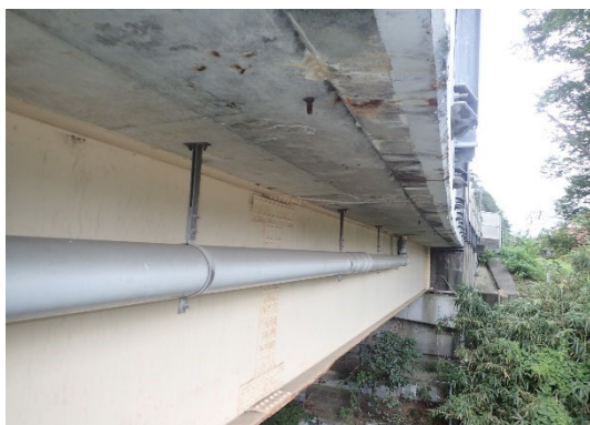
<滝沢川橋(小山)の橋梁全景>
