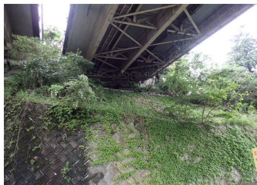
<馬伏川橋の橋梁全景>
