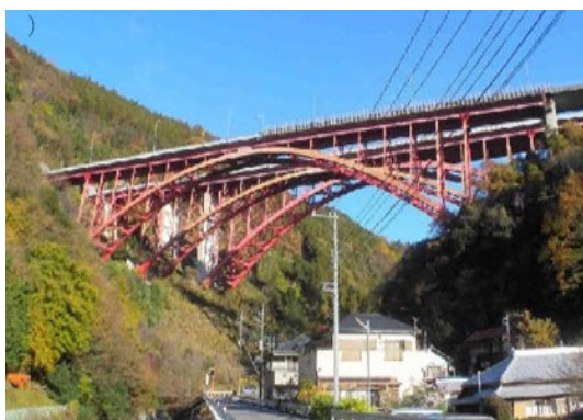
<皆瀬川橋の橋梁全景>
