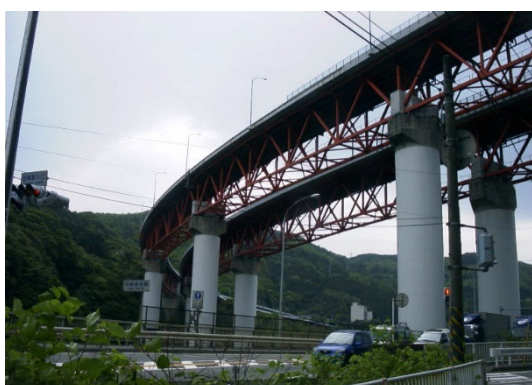
<酒匂川橋の橋梁全景>
