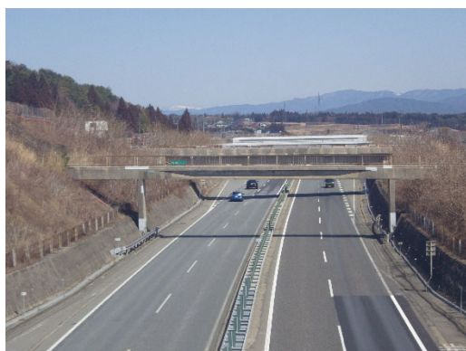
撤去する一番井水路橋（長野県管理）
