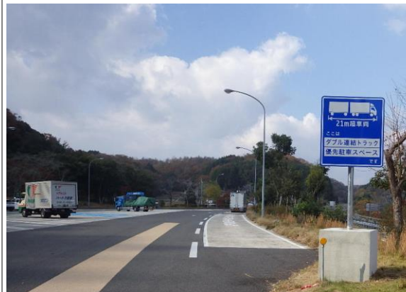
写真-1 E2A 中国道 江の川PA(下り線)
