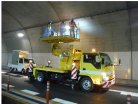
<トンネル照明設備点検>
