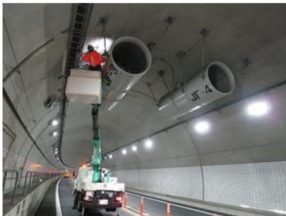
<トンネル点検>
