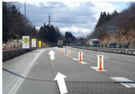
岡谷 IC（上り線）加速車線における交通安全対策イメージ
