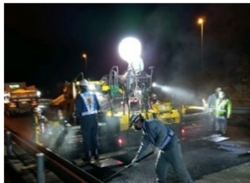
舗装の補修状況
