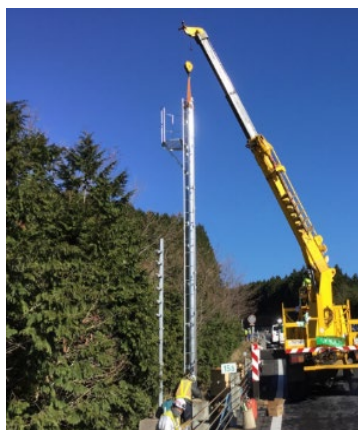
CCTV カメラ設備 設置状況
