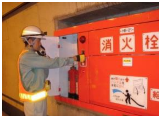
トンネル非常用設備の点検状況
