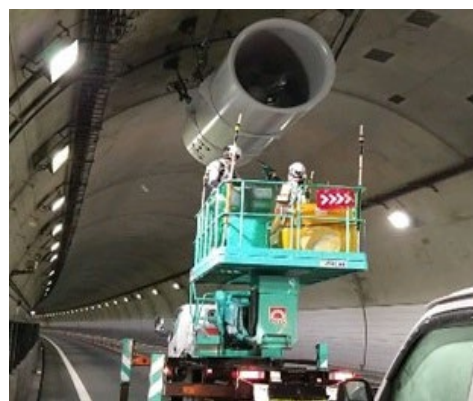
ジェットファンの点検状況
