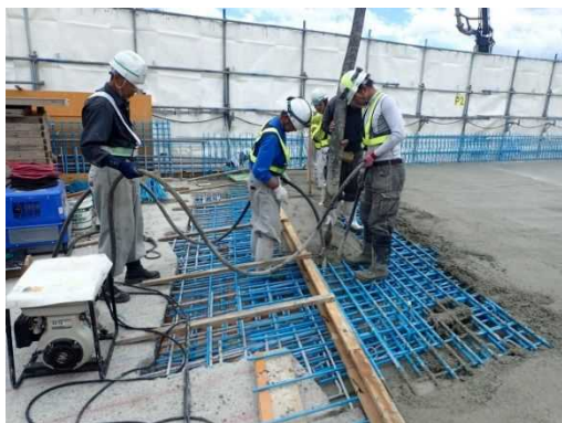
現場打ちコンクリート床版の施工
