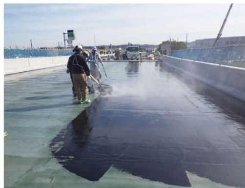
高性能床版防水の施工
