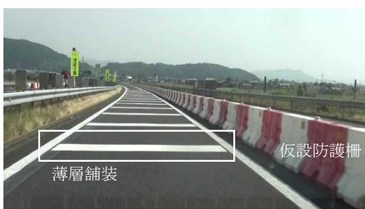
対面通行に移行する区間での仮設防護柵連続化・薄層舗装の設置例
