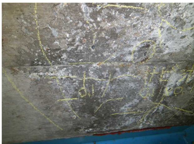
床版下面コンクリートのひび割れ状況
