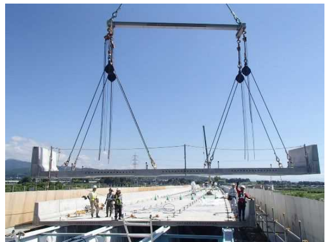
新しい床版の設置
