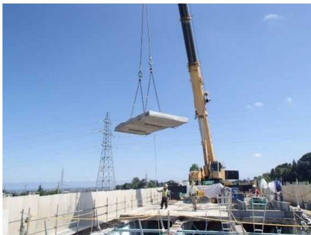
老朽化した床版の撤去
