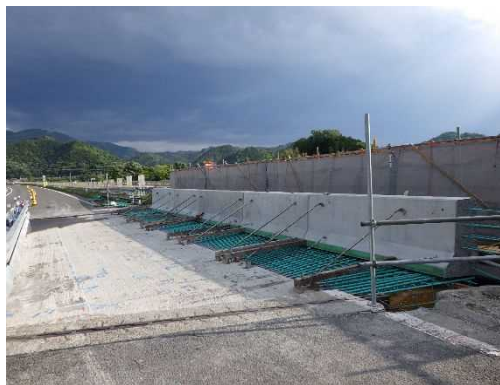
コンクリート製壁高欄の設置
