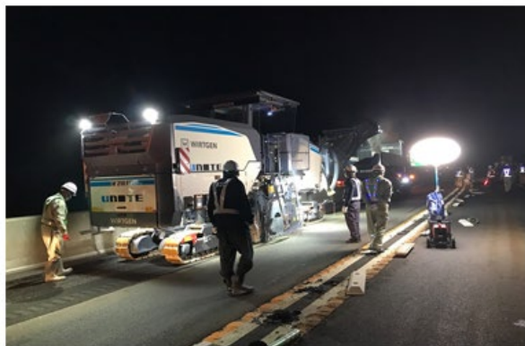
《傷んだ舗装の撤去》
