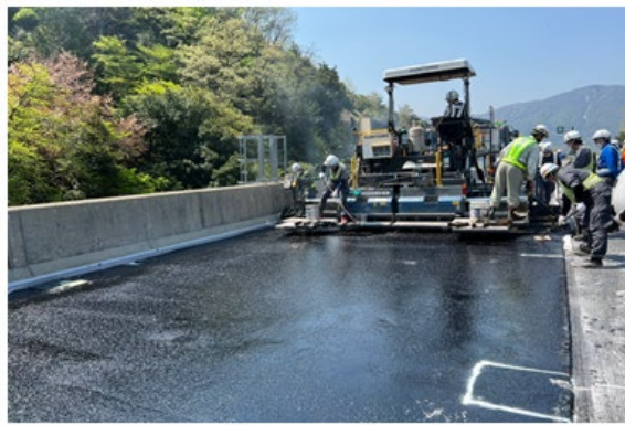
《床版防水工の施工》
