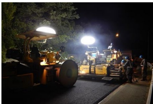
《路面損傷箇所の補修》
