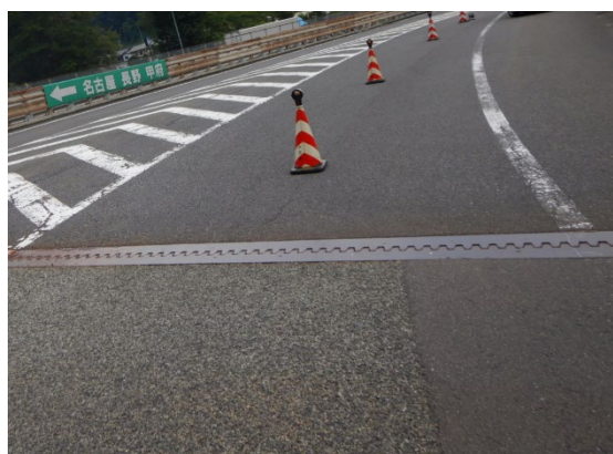
伸縮装置取替工事(イメージ)
