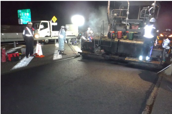
舗装補修の工事状況
