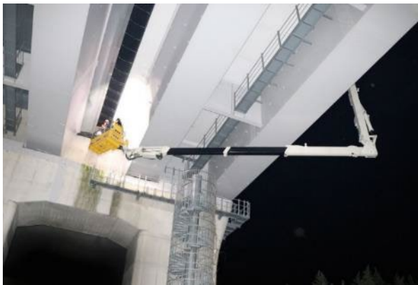
橋梁の点検状況
