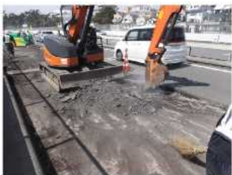
舗装撤去状況
