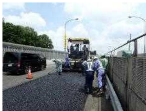
舗装工事イメージ
