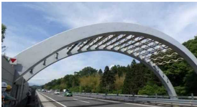
撤去予定の上空構造物の写真
