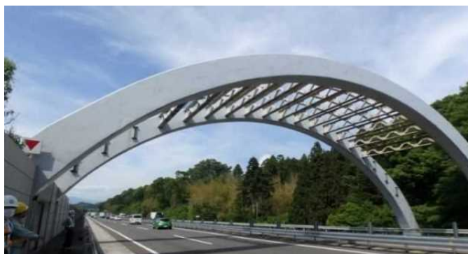
撤去予定の上空構造物の写真
