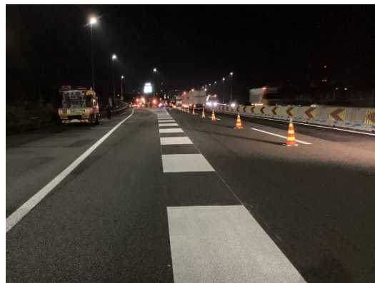
路面標示の書き換え状況(施工後)
