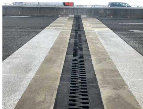
施工後の伸縮装置
