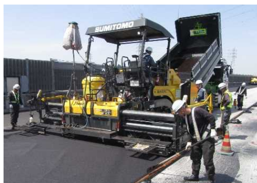
新たな舗装の施工状況
