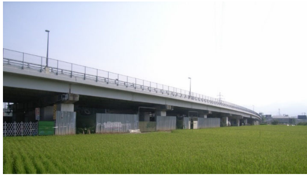
矢作高架橋の橋梁全景
