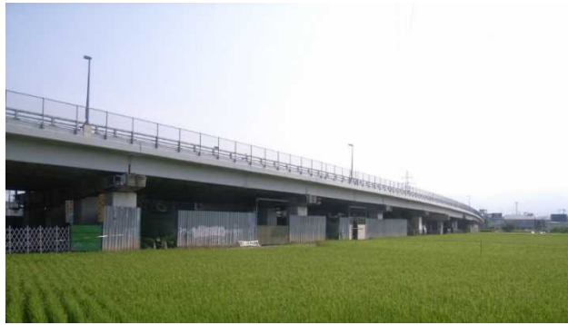
矢作高架橋の橋梁全景
