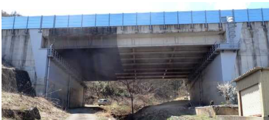
小田井沢川橋
