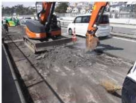
舗装撤去状況
