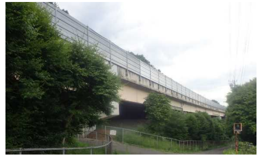
北真志野第二高架橋
