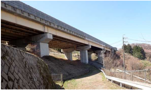
北真志野第一高架橋
