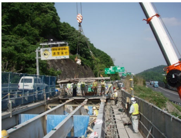
老朽化した床版の撤去
