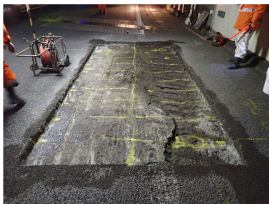
床版上面の状況
