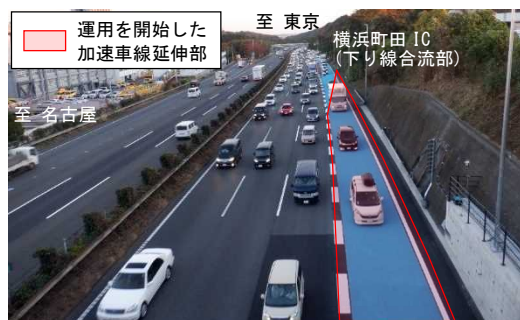
<横浜町田 IC（下り線）加速車線延伸（2022.11）>
