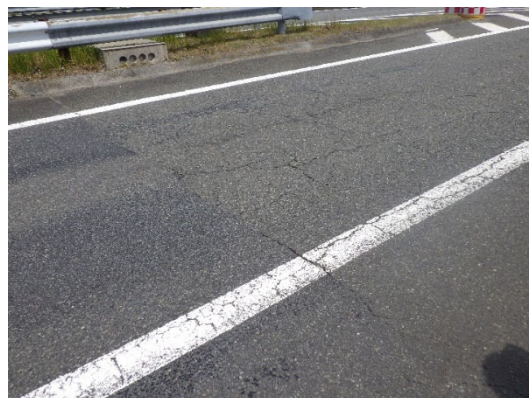
菊川 IC(下り線)出口の舗装損傷状況
