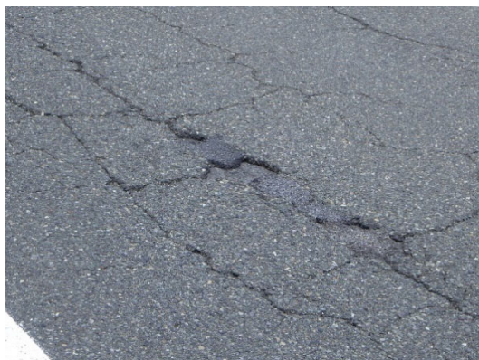
菊川 IC(下り線)出口の舗装損傷状況
