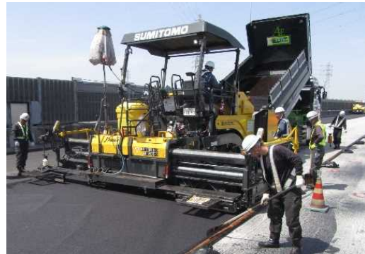
新たな舗装の施工状況
