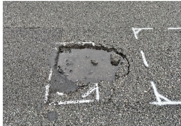
路面の損傷状況
