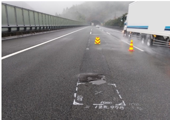
路面の損傷状況
