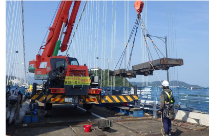
(新)大型伸縮装置の設置作業状況
