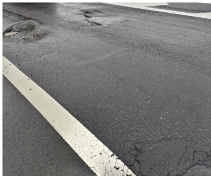
舗装の損傷状態イメージ
