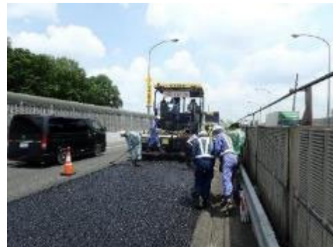
舗装工事イメージ
