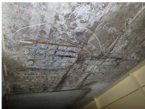
損傷状況（左写真：津島高架橋、右写真：佐屋高架橋）
