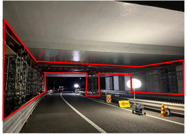
仮設構造物の設置状況
