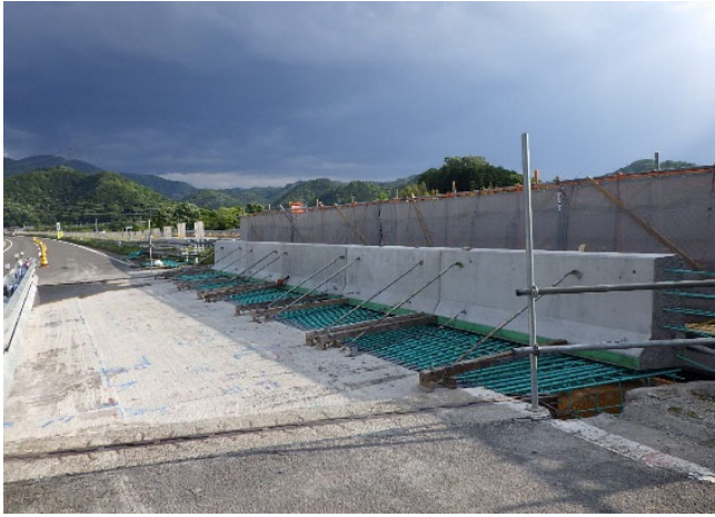
北陸道リニューアル工事における 本線橋の補修状況（イメージ）
