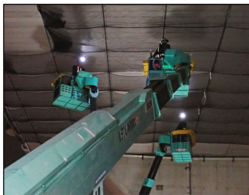
橋梁付属物(橋梁下面に設置されている吸音板)の補強工事
