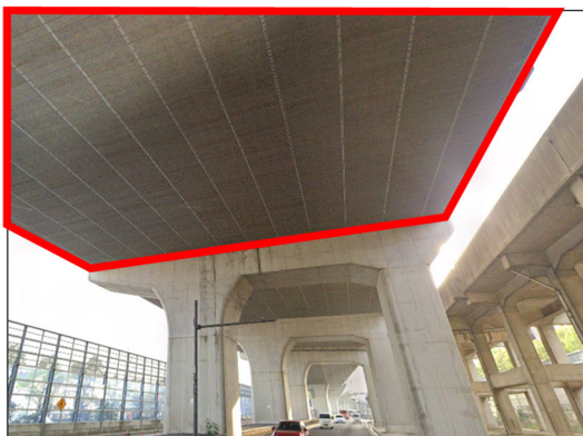
橋梁付属物(橋梁下面に設置されている吸音板)の補強工事
