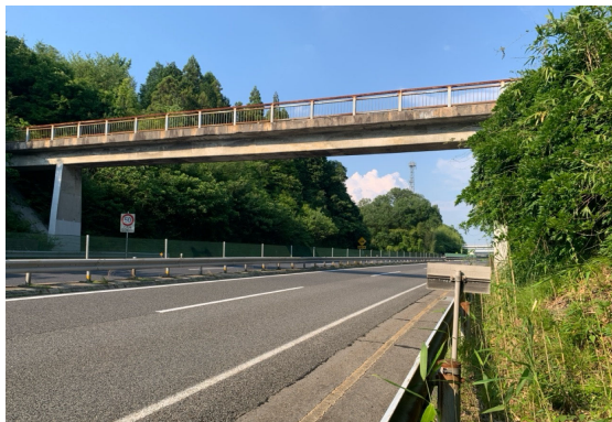
撤去する白山跨道橋（瑞浪市管理）
