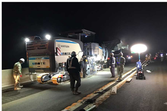
《傷んだ舗装撤去状況》
