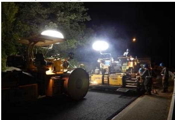
《路面損傷箇所の補修》
