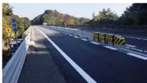
《センターブロック設置の例》
