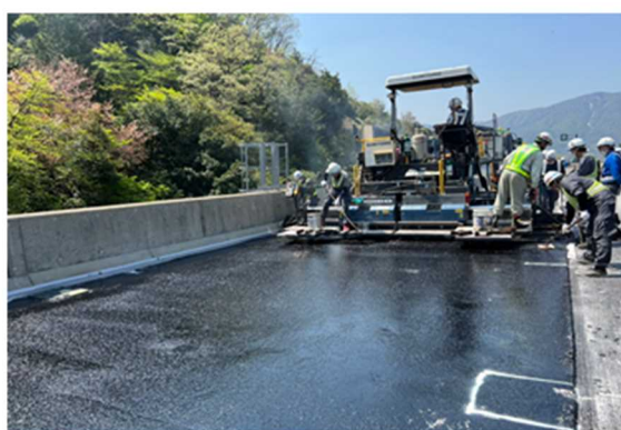
《床版防水工施工状況》
