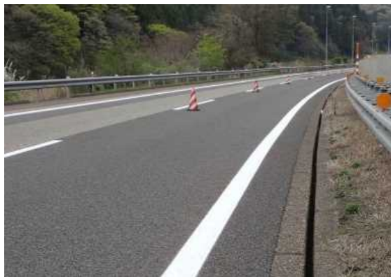
《路面標示工の施工》
