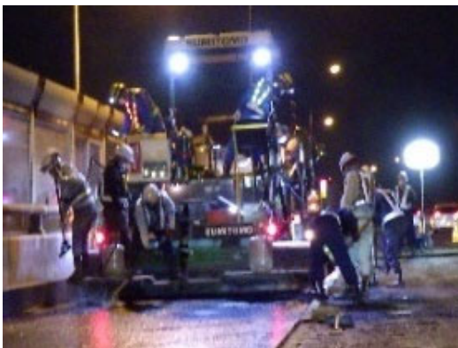
舗装工事(イメージ)
