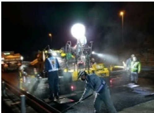
舗装工事のイメージ
