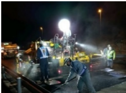
舗装工事のイメージ
