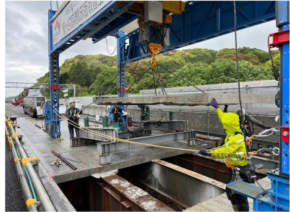
切断された床版をクレーンでつり上げて撤去
