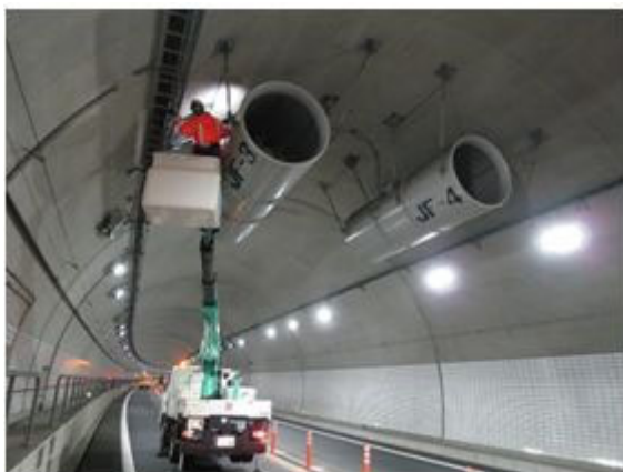
<トンネル点検>
