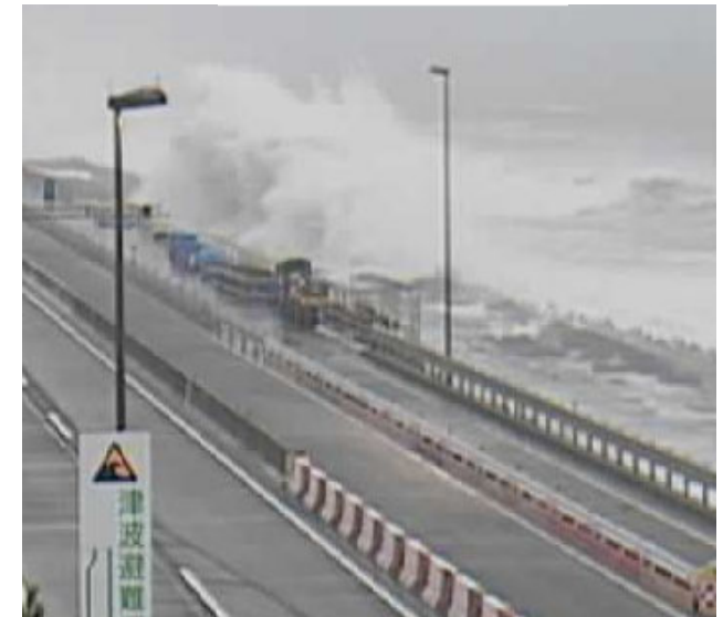
令和元年9月 神奈川県大磯町 国道1号
