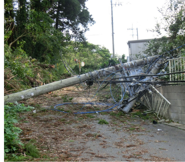
令和元年9月 千葉県山武市 山武市道
